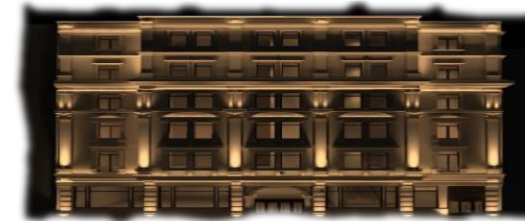
Rıhtım 51 (Karaköy) Hotel Project
